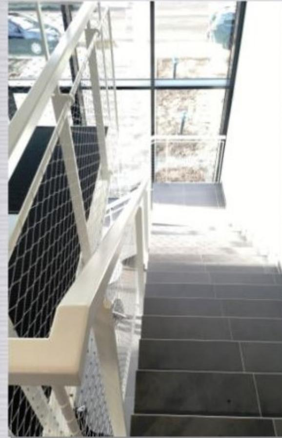
Transparente "Absturzsicherung" aus beschichtetem Stahlnetz
