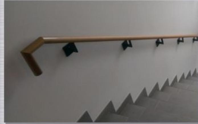
Geländer aus 10 mm Stahlblech und seitlich angesetzten Handläufen aus 40 mm Eichenholz, Natur geölt
